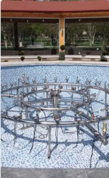
Halqa kollektorun quraşdırılması
