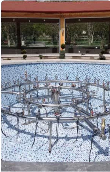
Instalación de colector en anillo
