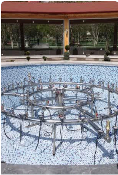
Сақиналы коллектор монтажи
