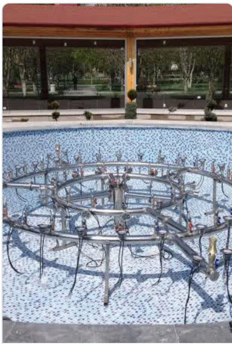
Монтаж кольцевого коллектора
