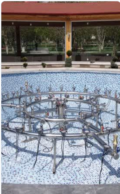
Montaža prstenastog kolektora
