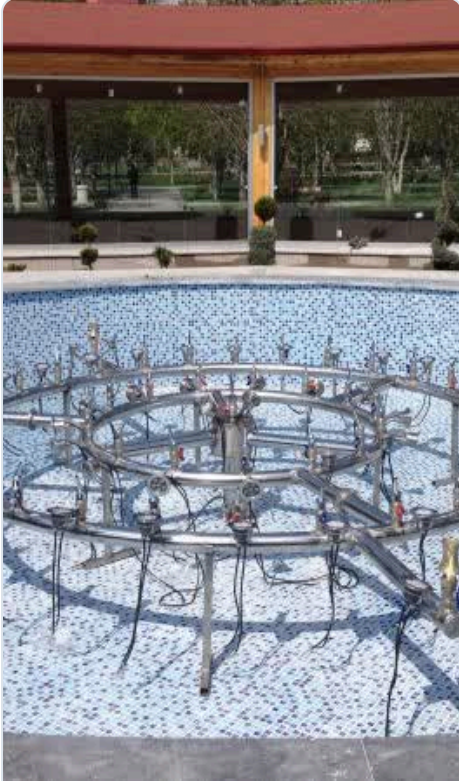
Halka kollektör montajı
